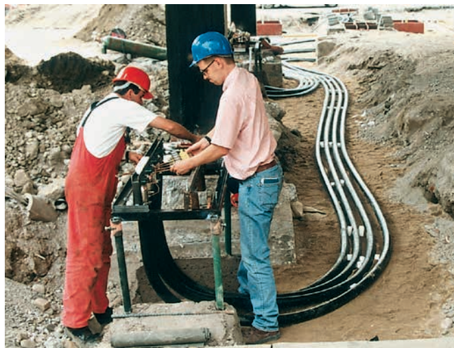
Montage der Anschluss Technik auf der Baustelle
